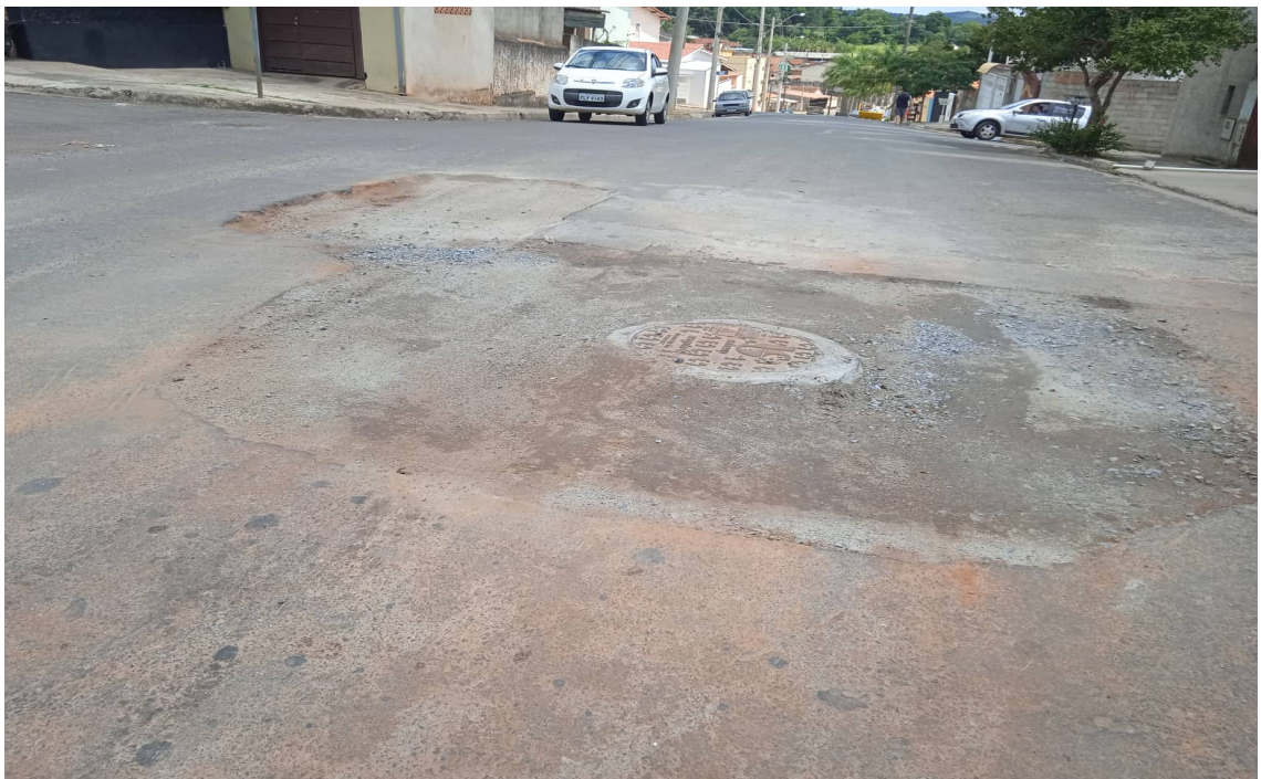
Rua Walter de Felippo, esquina com a rua dos Lírios
