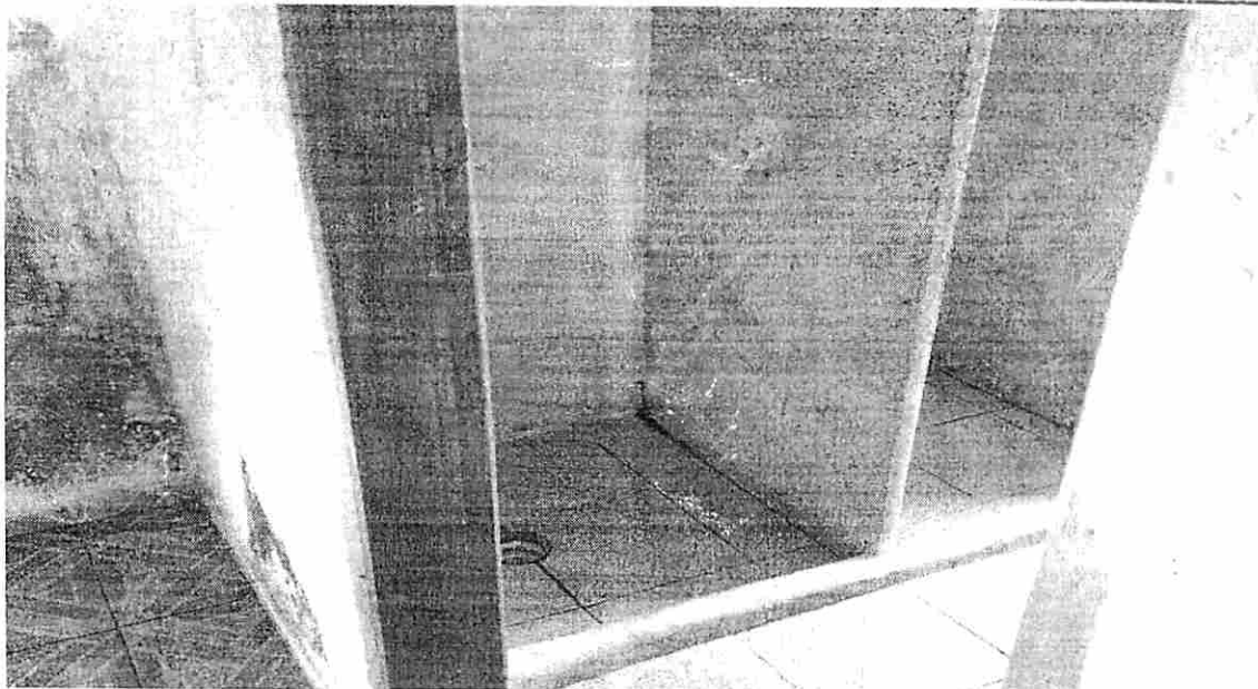
Foto 09) Vista do banheiro.
