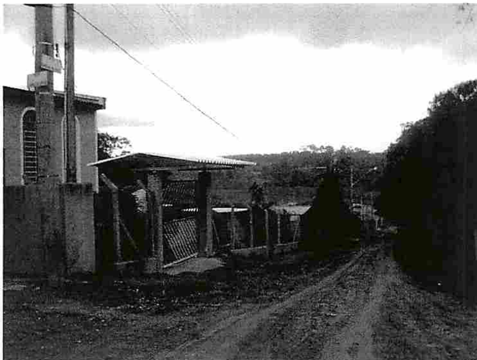
Foto 01 – Travessa Anésio da Cruz - Moradias com ligações de Energia elétrica;
