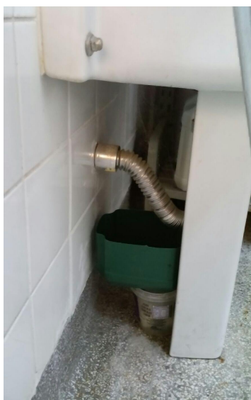
sifão com vazamento
