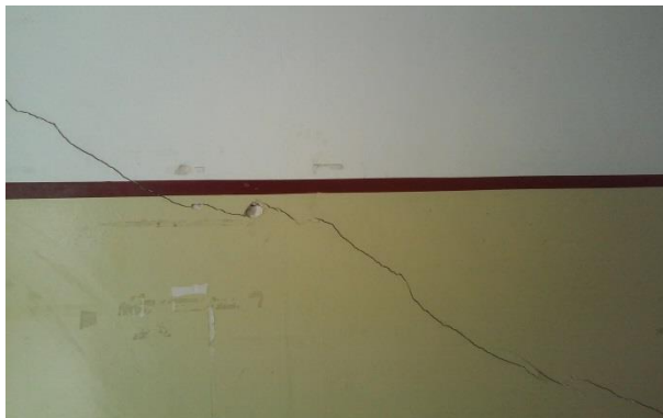
Rachaduras nas paredes e nos pisos
