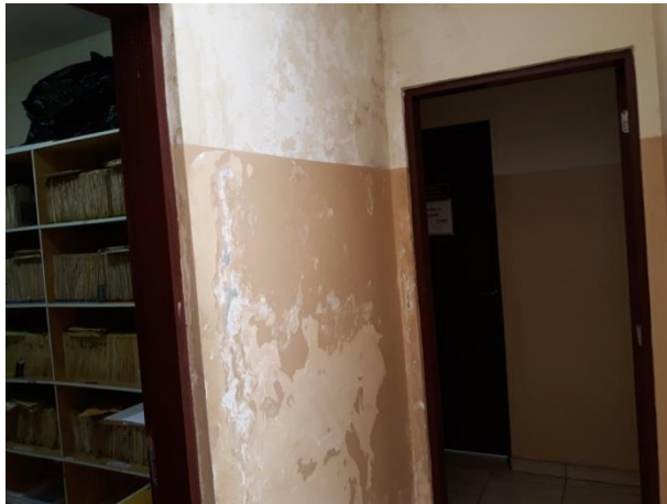
Pintura das paredes em condições precárias
