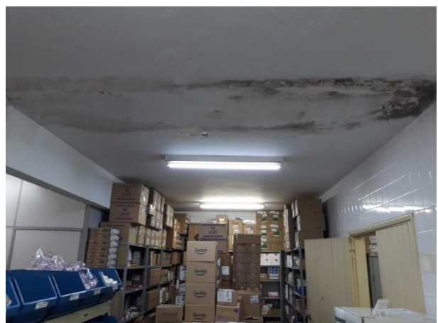
Infiltrações, mofo e acondicionamento irregular de medicamentos
