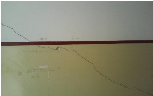
Rachaduras nas paredes e nos pisos
