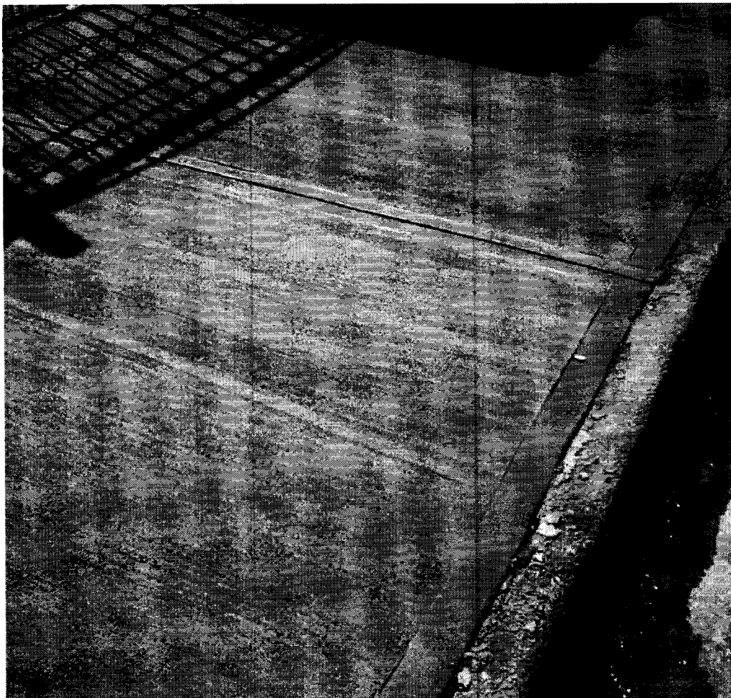
Foto 01 demonstrando o acabamento pretendido: Laterais e juntas de dilatação lisas e o centro com acabamento vassourado. Junta de dilatação perfeitamente reta.
