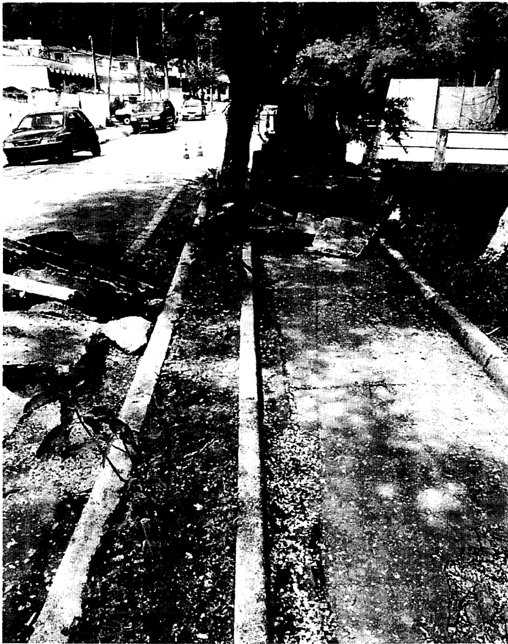
DEMOLIÇÃO DE PISOS E GUIAS DE CONCRETO
