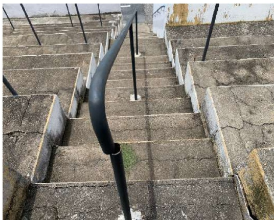
06/02/24 - Arquibancada - área de circulação - terceira fileira - barra de apoio danificada
