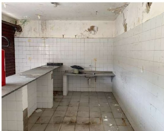
06/02/24 - Arquibancada - bar/ lanchonete - pintura desgastada e limpeza inadequada
