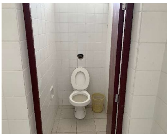
06/02/24 - Arquibancada - sanitário feminino - cabine sanitária 1 - sem tampa de válvula hidra
