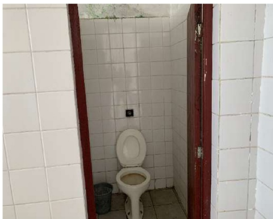
06/02/24 - Arquibancada - sanitário masculino - cabine sanitária 3 - sem tampa de válvula hidra
