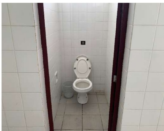
06/02/24 - Arquibancada - sanitário feminino - cabine sanitária 3 - sem tampa de válvula hidra
