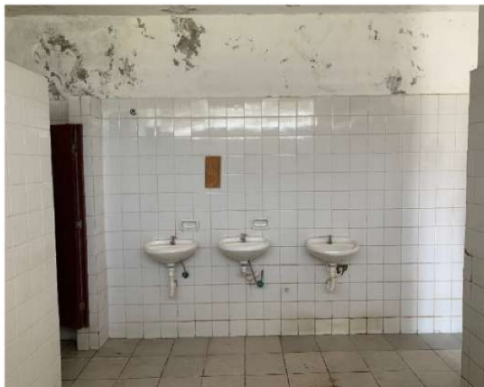
06/02/24 - Arquibancada - sanitário masculino - Sinais de infiltração nas paredes e teto
