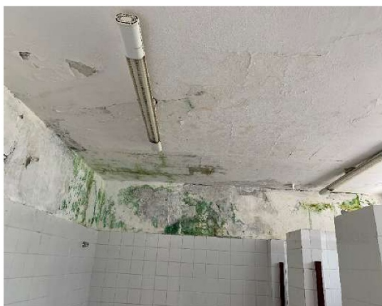
06/02/24 - Arquibancada - sanitário feminino - paredes e teto com sinais de infiltração
