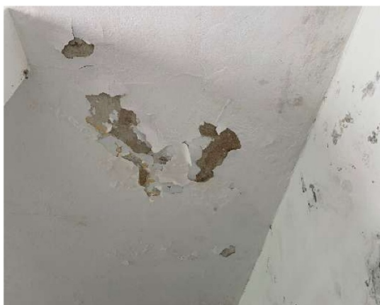
06/02/24 - Arquibancada - sanitário masculino - Sinais de infiltração nas paredes e teto
