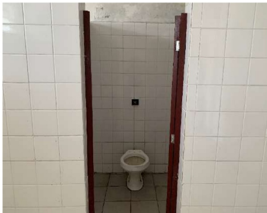
06/02/24 - Arquibancada - sanitário masculino - cabine sanitária 2 - sem tampa de válvula hidra
