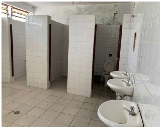
06/02.24 - Arquibancada - sanitário masculino - sem cabine sanitária adaptado
