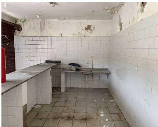
06/02/24 - Arquibancada - bar/ lanchonete - teto e paredes com sinais de infiltração
