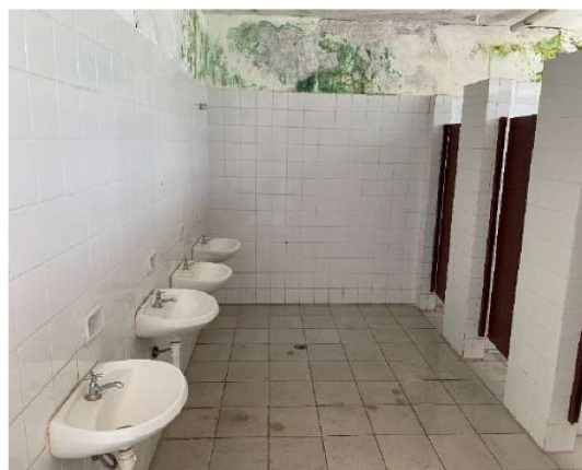
06/02/24 - Arquibancada - sanitário feminino - parede com sinais de infiltração
