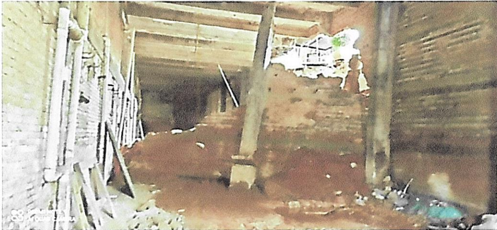
Foto 44: vista da parte direita da cortina, observando-se seu deslocamento por escorregamento sem tombamento, mas "girando no plano horizontal.
