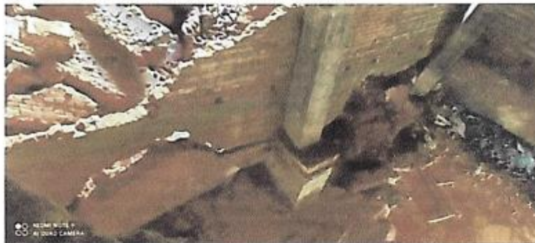
Foto 45: vista de cima da parte direita da cortina, permitindo observar que após a sua movimentação manteve praticamente intacto o prumo.
