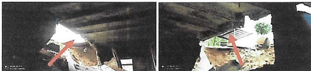
Fotos 09 e 10: destinadas a ilustrar o sistema estrutural na região do desabamento e assinalada a viga citada.
