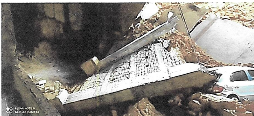
Foto 37: visão geral da ruína de uma das partes da cortina que escorregou e tombou.
