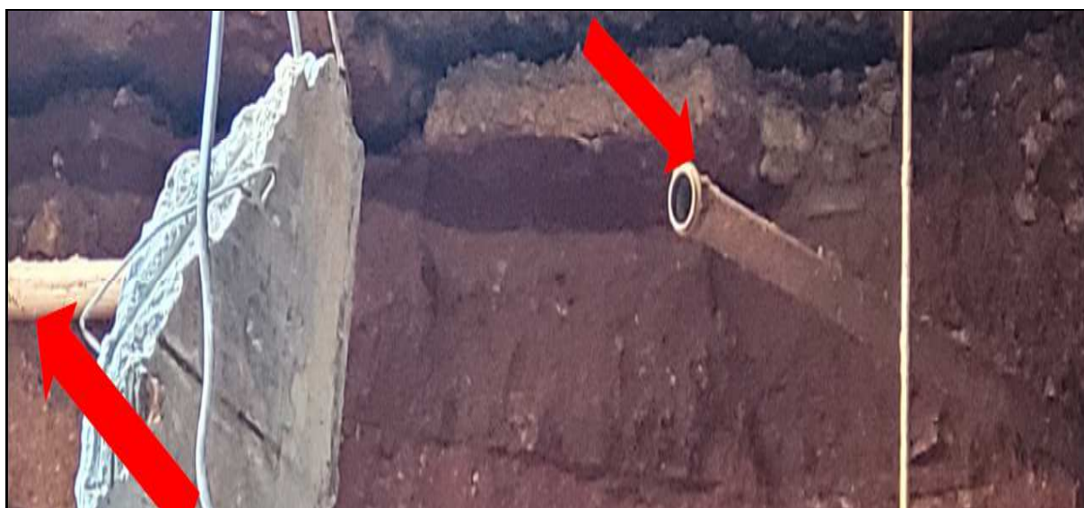
Detalhe da falha. Canos de rede.
