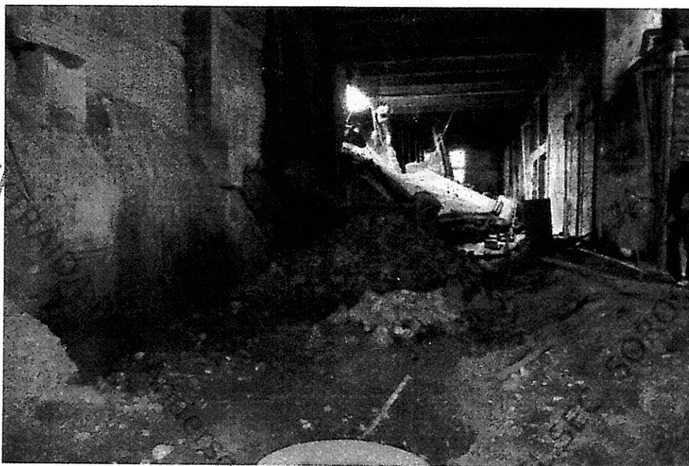
Fotografia 16: Vista geral da área interna onde, ao fundo, observa-se o ponto onde rompeu a estrutura de arrimo
