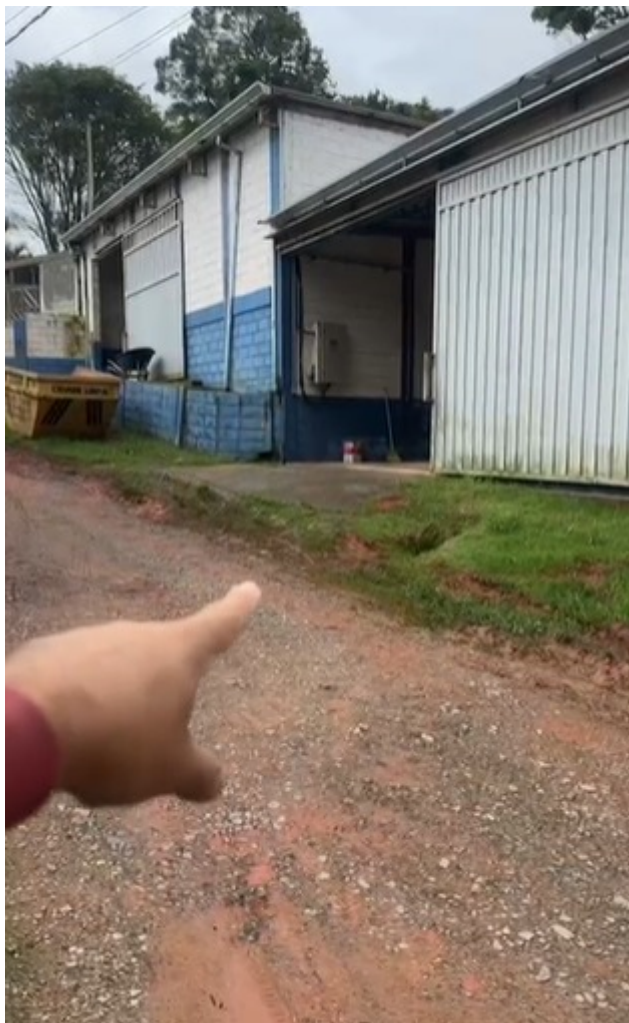
Desnível da rua com relação a “calçada” – dificultando o acesso ao comércio
