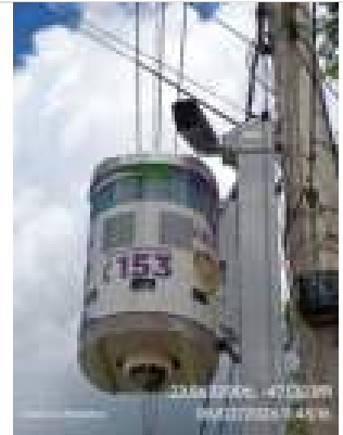
Fotos Gerais Geradas na Vistoria:
