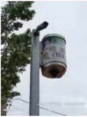
Fotos Gerais Geradas na Vistoria:
