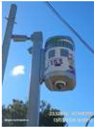
Fotos Gerais Geradas na Vistoria:
