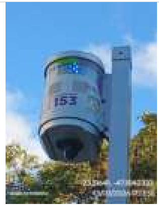
Fotos Gerais Geradas na Vistoria:
