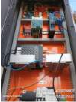
Fotos Gerais Geradas na Vistoria:
