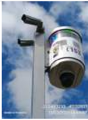
Fotos Gerais Geradas na Vistoria:
