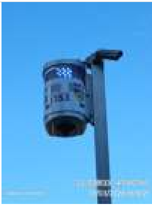
Fotos Gerais Geradas na Vistoria:
