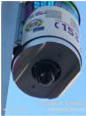
Fotos Gerais Geradas na Vistoria:
