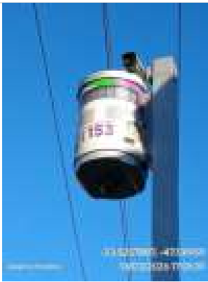
Fotos Gerais Geradas na Vistoria:
