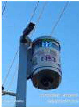
Fotos Gerais Geradas na Vistoria:
