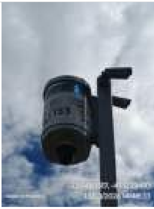
Fotos Gerais Geradas na Vistoria:
