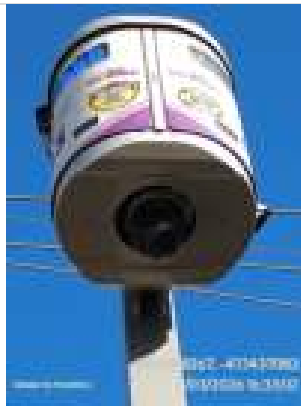
Fotos Gerais Geradas na Vistoria:
