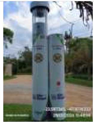
Fotos Gerais Geradas na Vistoria:
