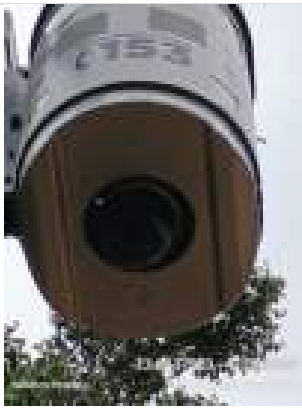
Fotos Gerais Geradas na Vistoria:
