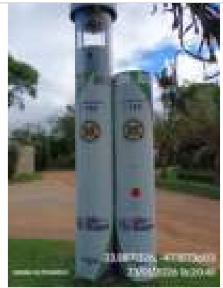
Fotos Gerais Geradas na Vistoria:
