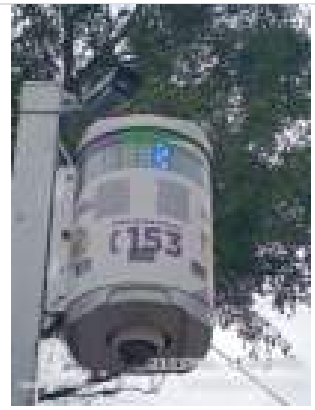
Fotos Gerais Geradas na Vistoria:
