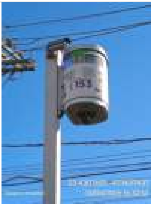
Fotos Gerais Geradas na Vistoria:
