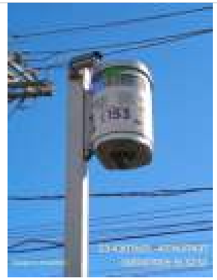
Fotos Gerais Geradas na Vistoria:
