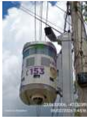
Fotos Gerais Geradas na Vistoria:
