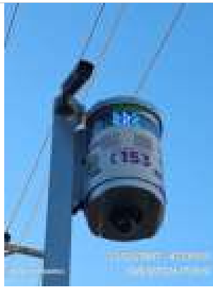
Fotos Gerais Geradas na Vistoria:
