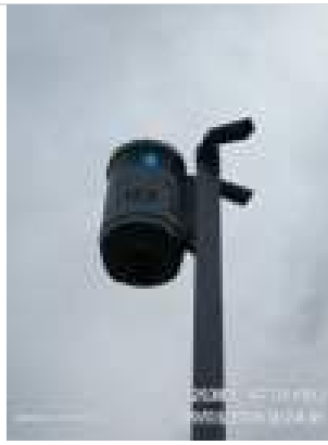
Fotos Gerais Geradas na Vistoria:
