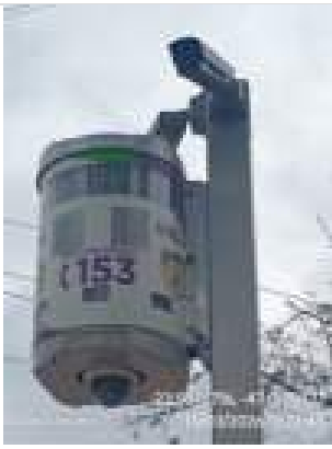
Fotos Gerais Geradas na Vistoria:
