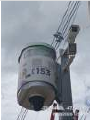
Fotos Gerais Geradas na Vistoria:
