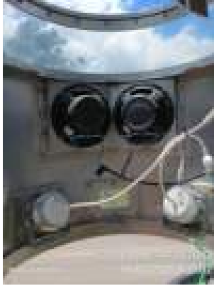
Fotos Gerais Geradas na Vistoria:
