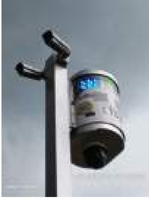
Fotos Gerais Geradas na Vistoria:
