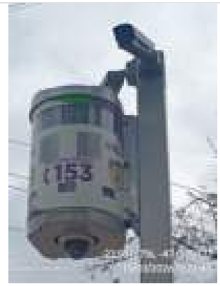
Fotos Gerais Geradas na Vistoria:
