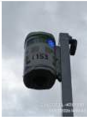
Fotos Gerais Geradas na Vistoria:
