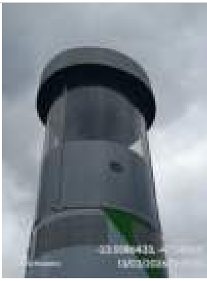
Fotos Gerais Geradas na Vistoria:
