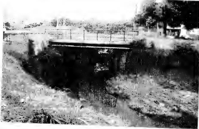
Ponte queda da parede lateral.
