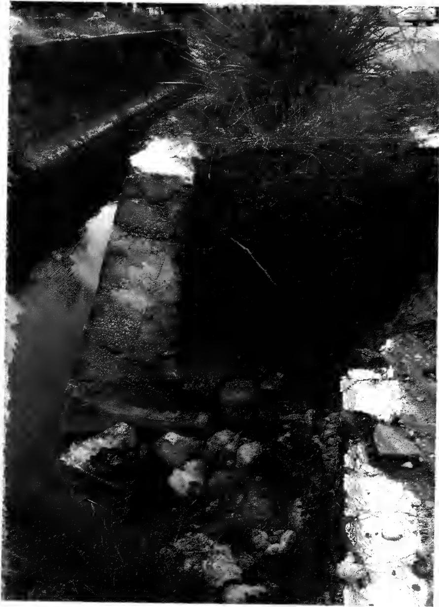
Foto 5 → Base do muro de contenção ciclope apresentando inclinação.
